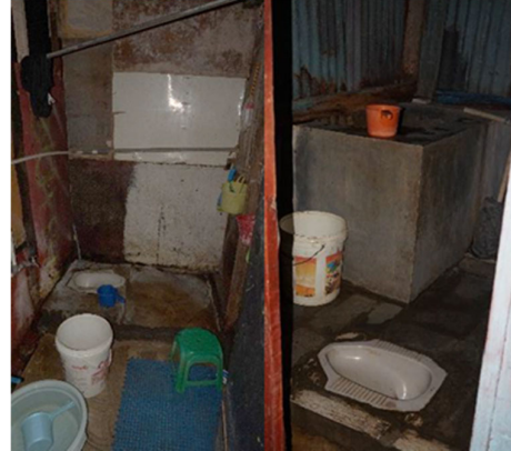
Gambar 5. Kondisi kamar mandi rumah warga jalan LC Jatayu [Sumber: Pribadi, 2024]
