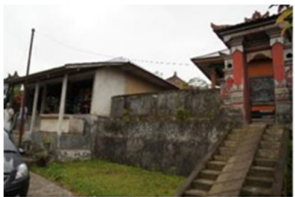
Gambar 5. Penambahan bangunan untuk toko [Sumber: Dokumentasi peneliti,2024 ]
