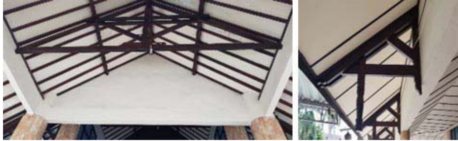
Gambar 7. Konstruksi kayu dan detail ornamen pada atap Masjid Agung Nurul Huda Sumber foto: dokumentasi pribadi
