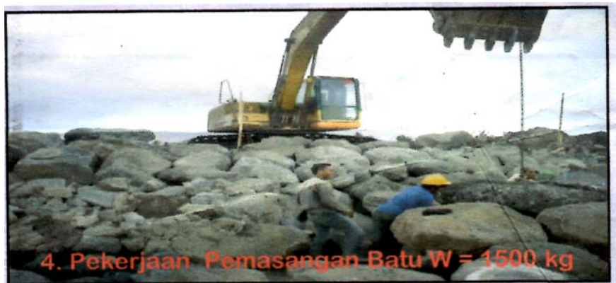
Gambar 9 (b) Pekerjaan Pemasangan Batu dengan Berat (Weight), W = 1500 \text{ Kg} , diatas batu W = 100 \text{ Kg} .
