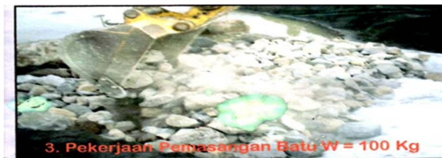
Gambar 9 (a) Pekerjaan Pemasangan Batu dengan Berat ( Weight ), W = 100 Kg, diatas Geotextile. Sumber : Kementerian Pekerjaan Umum, Direktorat Jenderal Sumber Daya Air Balai Wilayah Sungai Bali – Penida Propinsi Bali.
