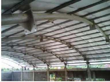
Gambar 6. Struktur Pipa Baja Sumber : Analisa Pribadi, 2019
