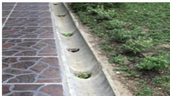
Gambar 9. Lubang resapan biopori pada dasar saluran
