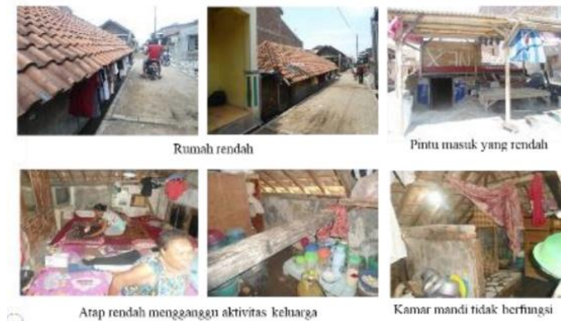
Gambar 10. Kondisi Eksisting Rumah yang Rendah Sumber : Anita, 2020
