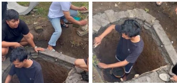
Gambar 7. Proses Pemasangan Fondasi (Analisis Penulis, 2024)
