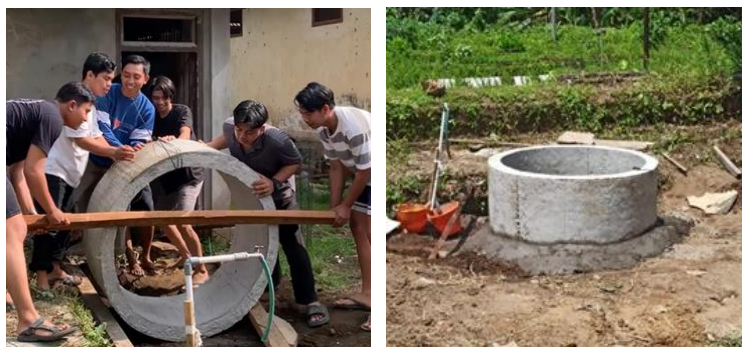
Gambar 8. Proses Pemasangan Buis Beton (Analisis Penulis, 2024)
