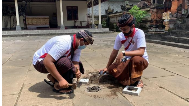
Gambar 2. Pemasangan Paving Biopori pada Fasilitas Umum Desa Adat Negara oleh Mahasiswa
