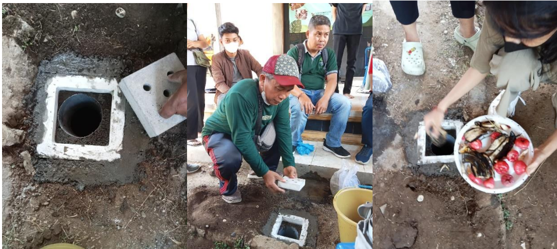
Gambar 6. Biopori tempat Pembuangan Sampah Organik dalam Pembuatan Pupuk Organik (Sumber: Dokumen Pribadi)
